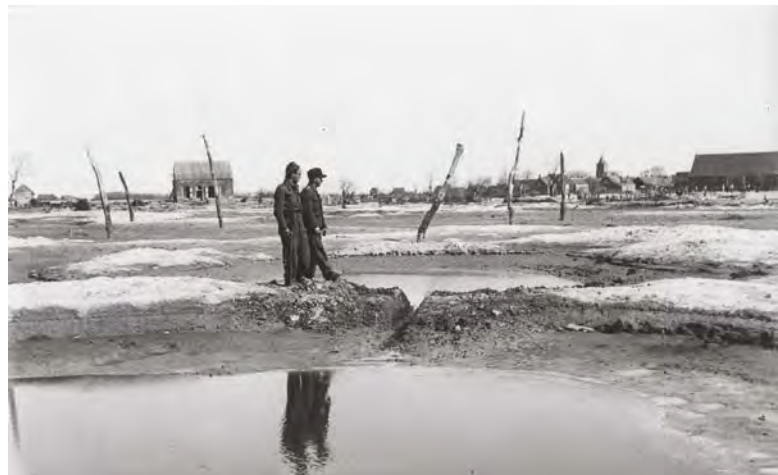
Een beeld van het overspoelde land van Walcheren, waarna het Herstelplan Walcheren is opgesteld.
