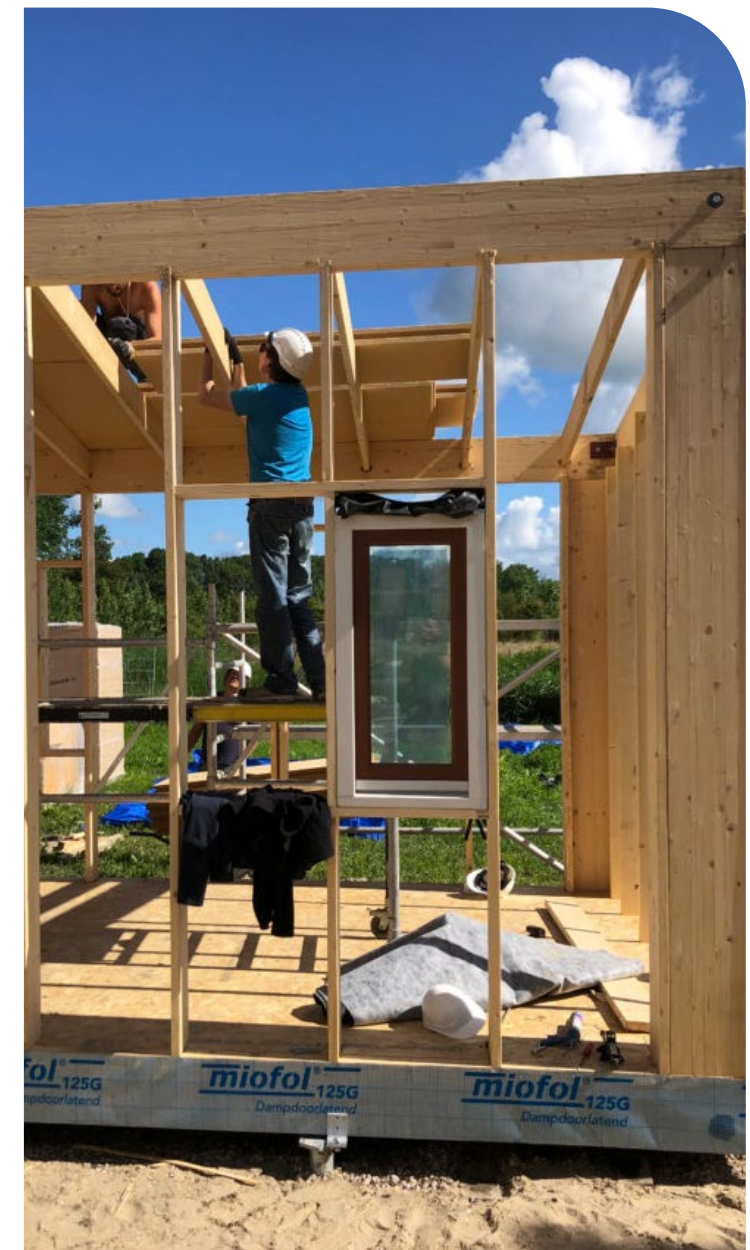
Figuur 9 - Kleine woning in aanbouw (beeld: LiberTerra)
