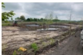
AANLEG POEL OOSTERWOLDE
